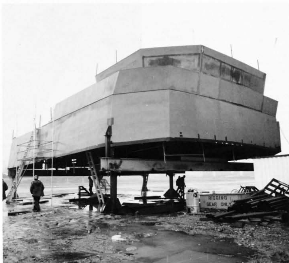
Élément de montage — Cet élément de montage 4110 vient de recevoir une couche d'apprêt dans l'installation de décapage au jet et de peinture. La superstructure de pont est un élément de montage résultant de l'assemblage des éléments unifiés 4110, 4120, 4210 et 4220.
