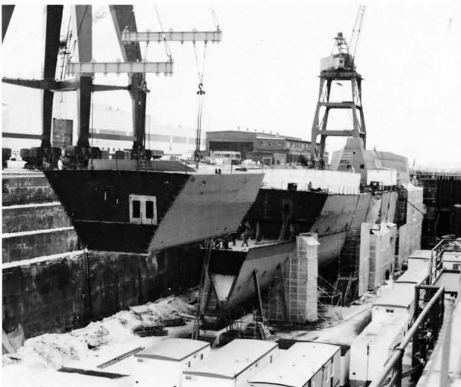
Bassin de radoub — Environ le quart du travail nécessaire à la construction d'une FCP s'accomplit à ce poste de travail. Sur la photo, l'élément de montage 1250 est abaissé en position.
