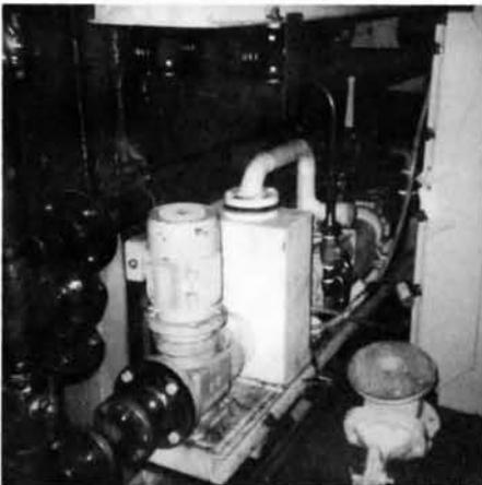
Radier pour la pompe à vide du système de collecte des eaux-vannes du *Terra Nova*
