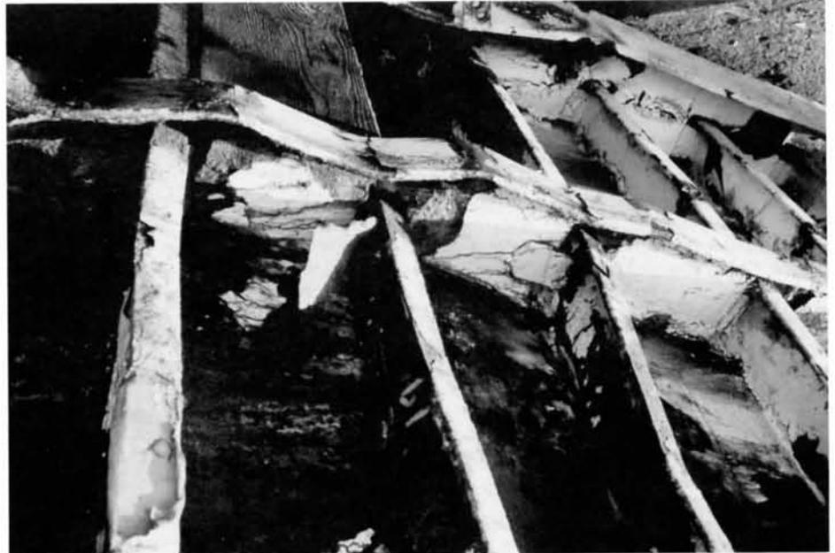
Fig. 1. La structure extrêmement corrodée que l'on trouve dans le compartiment des machines est une preuve flagrante d'un manque d'inspection et de réparation.
