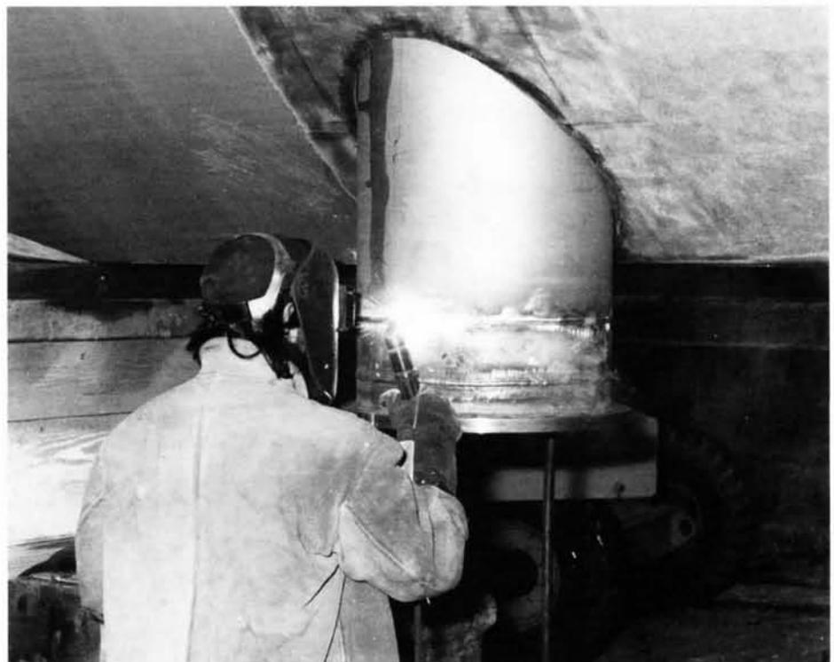
**Fig. 3 Tube à la mer du système CTS-36 sur le *Restigouche*. (Photographie de la base d'Esquimalt)**
