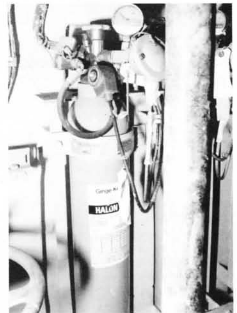
Prévention d'incendie, mais à quel prix? Les classes DDH-280 et FFH-330 se fient énormément aux systèmes à halon 1301 comme celui-ci à bord du NCSM Halifax.
