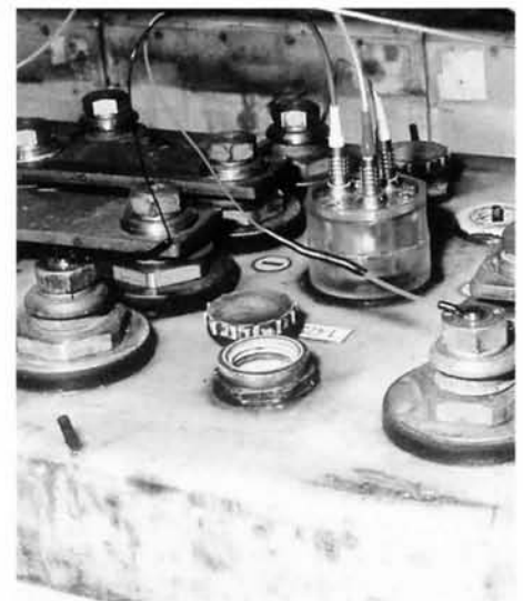
Fig. 4. Sonde de batterie installée dans un élément
