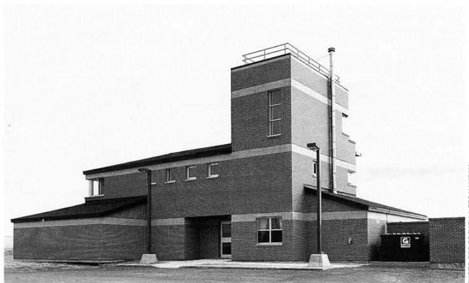
Le bâtiment William MacKay Creelman qui abrite l'installation de mesure d'influence de Fergusons Cove.
