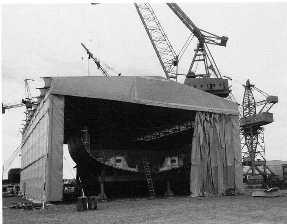
Fig. 8. Abri temporaire pour le NCSM Halifax
