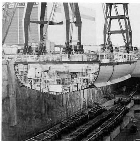
Fig. 14. Mise sur cale du NCSM Charlottetown
