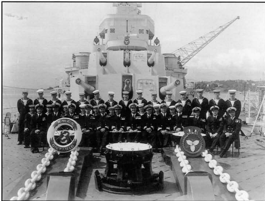
La section d'électricité du navire en 1952. (Photographie d'archives du MDN, OT-2432)
