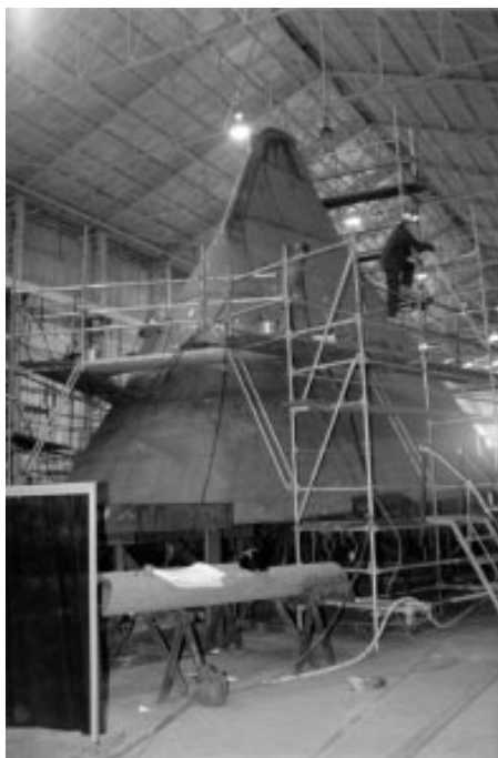
Module d'étrave du NCSM Nanaimo . Les éléments sont à l'envers pour en faciliter le soudage selon la technique à plat. Les éléments terminés sont ensuite remis à l'endroit avant l'assemblage des modules. Compte tenu de la cadence de construction et de l'espace restreint au chantier de HSL, les modules d'étrave des NDC 04 à 12 sont construits au chantier East Isle Shipyards (EISL) de Georgetown (I.-P.-É.). Les pièces sont amenées au chantier EISL sur des semi-remorques plateau et sont ensuite ramenées par barge une fois le module d'étrave assemblé. (HSC95-0840-13)
