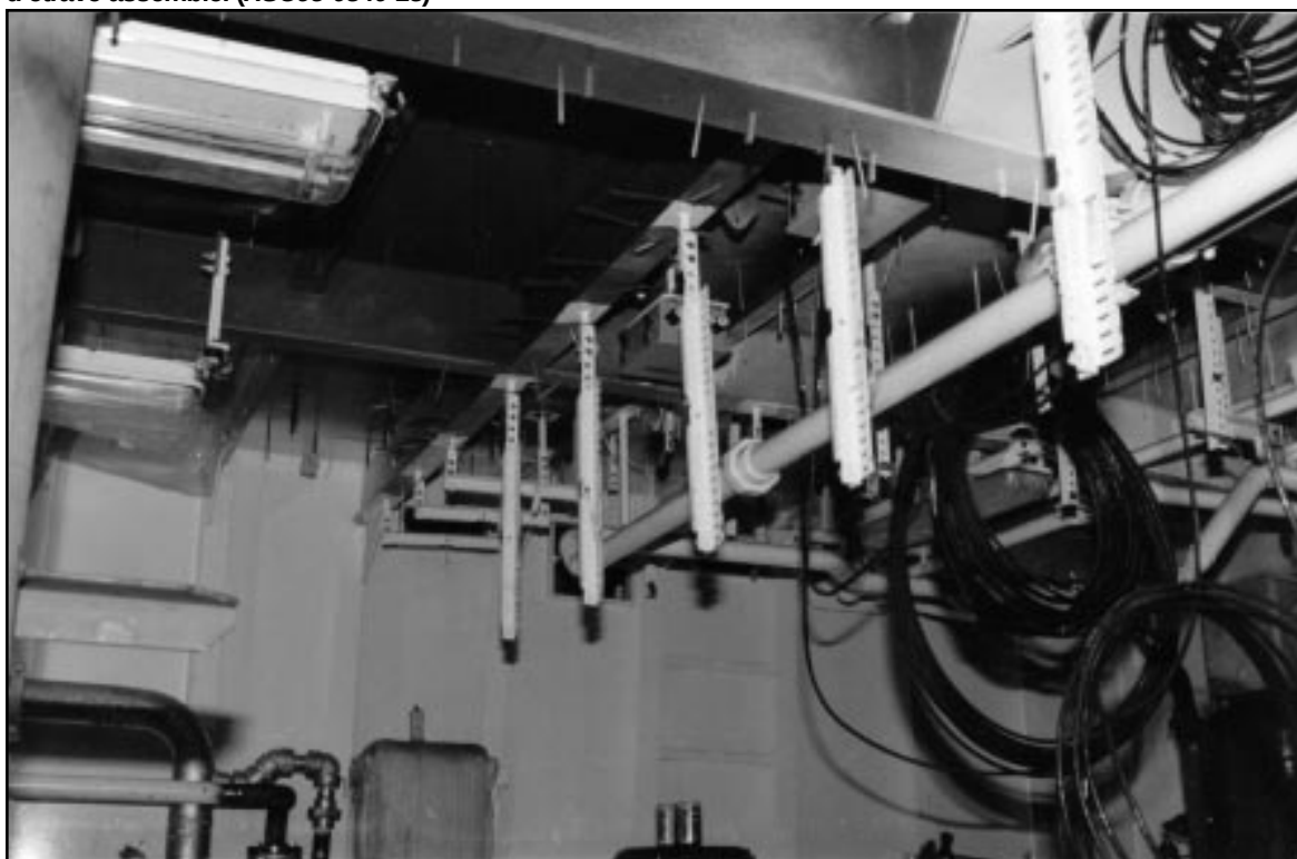
Pré-armement de la salle des moteurs du NCSM Nanaimo . Les travaux de peinture, de tirage des câbles et de pose de l'isolant sont déjà en cours. L'armement de cet élément est beaucoup plus avancé que dans le cas du Kingston et du Glace Bay à la même étape de construction. HSL continue à perfectionner ses procédés de construction afin de réduire le plus possible les coûts et les travaux de reprise. (HSC95-0840-16)
