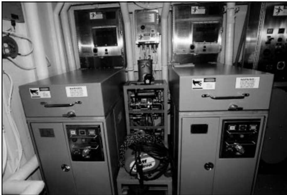
Le système de traitement des déchets de matières plastiques à bord NCSM Fredericton. (Photo : BFC Halifax par le Sdt. S. Kent)
