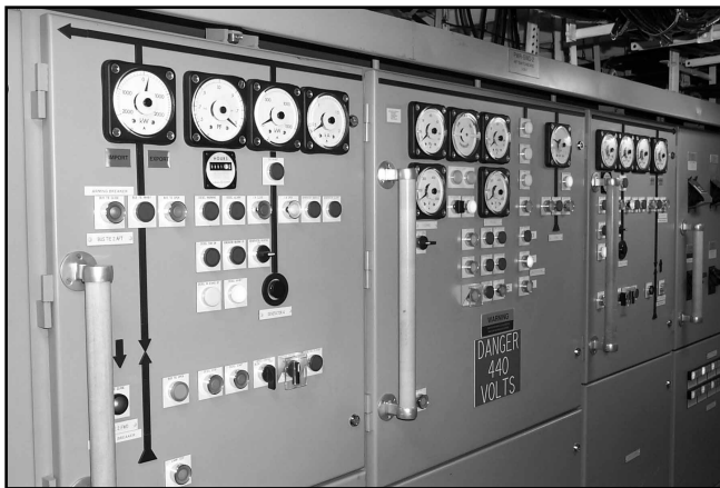
Figures 2 et 3. Dans cet exemple d'équipement des frégates de la classe Halifax , les deux unités de commande de groupe électrogène situées de part et d'autre d'une unité en parallèle constituent la pratique de conception standard en propulsion mécanique classique. Comparez avec l'élément numérique unique indépendant de la Fig. 3 , qui montre l'élégance et l'efficacité de l'intégration directe du matériel et des logiciels dans la conception électrique. L'unité numérique fait tout et, à la différence de la technologie analogique, peut fonctionner de façon indépendante. Un coup d'œil à l'intérieur de l'armoire montre la disposition fonctionnelle et impeccable des composants d'un système intégré tout numérique.
