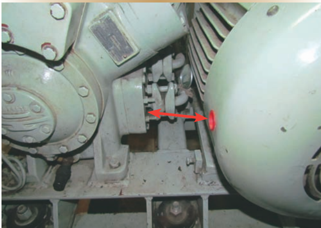
Figure 2. Vue rapprochée du peu d'espace entre le moteur et le compresseur. Le verre-regard se trouve vers la gauche.
