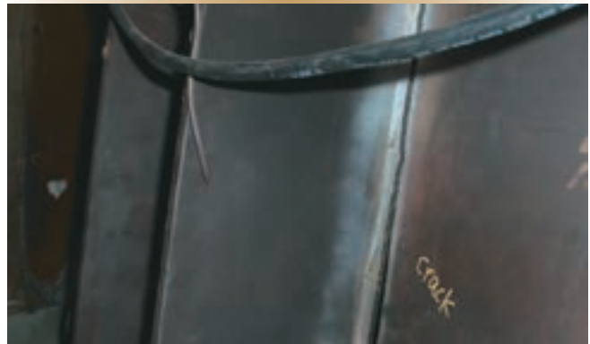
Figure 1b. Un simple mot si éloquent. Une fissure due à la fatigue est causée par la dilatation thermique que subit l'enveloppe de la prise d'aspiration, mais elle est limitée par le raidisseur externe.
