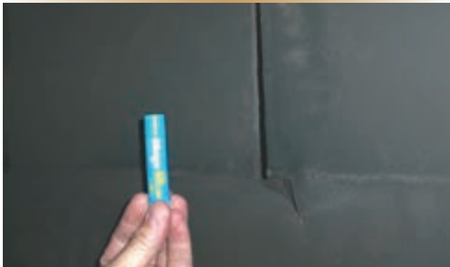
Figure 1a. Il faudra plus qu'une retouche esthétique pour colmater cette fissure causée par les conditions thermiques le long du raidisseur vertical principal du conduit de fumée de la turbine à gaz de tribord du NCSM Montréal .
