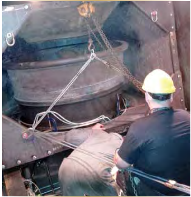
Figure 9 – Les valeurs de dégagement étaient d'aussi peu que 3 mm quand la conduite d'échappement a été déplacée avec soin à travers l'enceinte pour son retrait.
