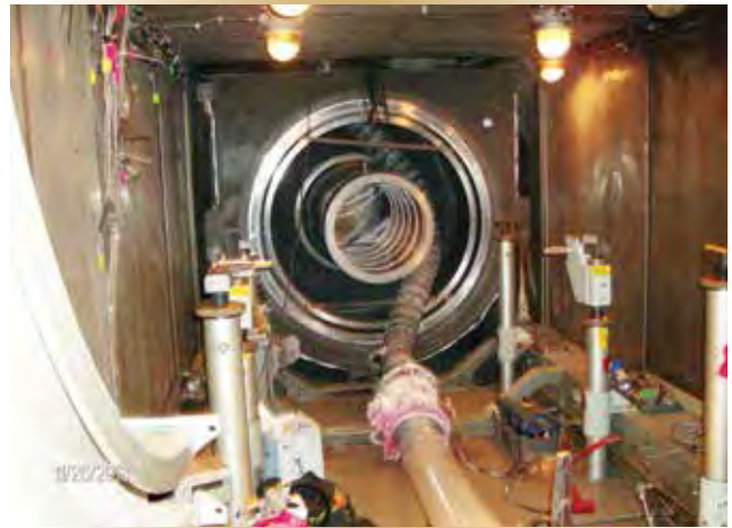
Figure 10 – Les travaux se sont poursuivis 24 heures sur 24 et 7 jours sur 7. Dans cette photo, l'équipe de nuit du côté du rivage abaisse un nouveau diffuseur dans la nouvelle conduite d'échappement, puis met en place celle-ci dans l'enceinte du moteur.
