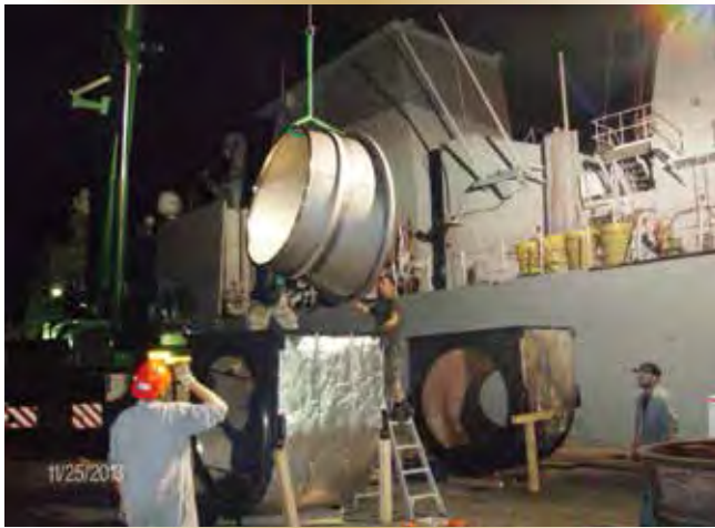
Figure 10 – Les travaux se sont poursuivis 24 heures sur 24 et 7 jours sur 7. Dans cette photo, l'équipe de nuit du côté du rivage abaisse un nouveau diffuseur dans la nouvelle conduite d'échappement, puis met en place celle-ci dans l'enceinte du moteur.
