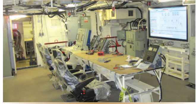
Le même espace sur le NCSM Charlottetown suite au carénage.
