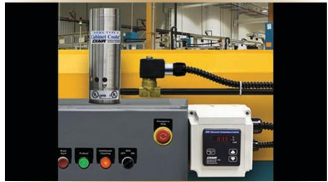
Figure 5. Système de refroidissement d'enceinte EXAIR NEMA 4X avec thermostat et régulateur de température électronique
