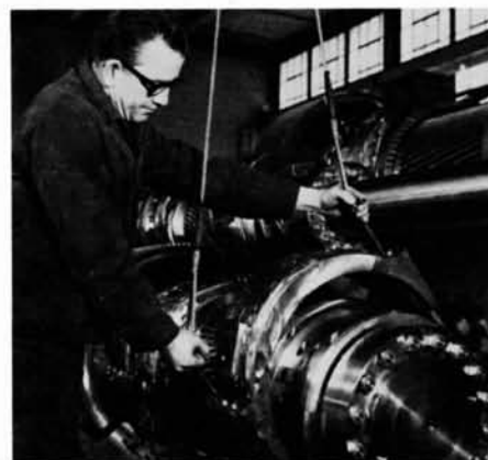
7. ... et les couverts de palier installés.
