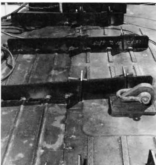
Fig. 8 En préparation du soudage final, des renforts sont soudés et calés dans des supports à encoches de chaque côté de la ligne de soudage pour empêcher la distorsion.
