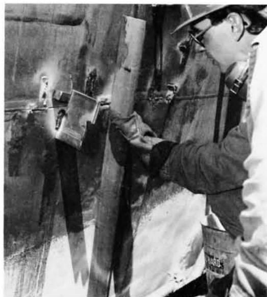
Fig. 7 Carénage de la coque à l'aide de supports en L.
