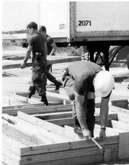
**Des équipes canadiennes préfabriquent des charpentes et des armatures en vue de la reconstruction.**
