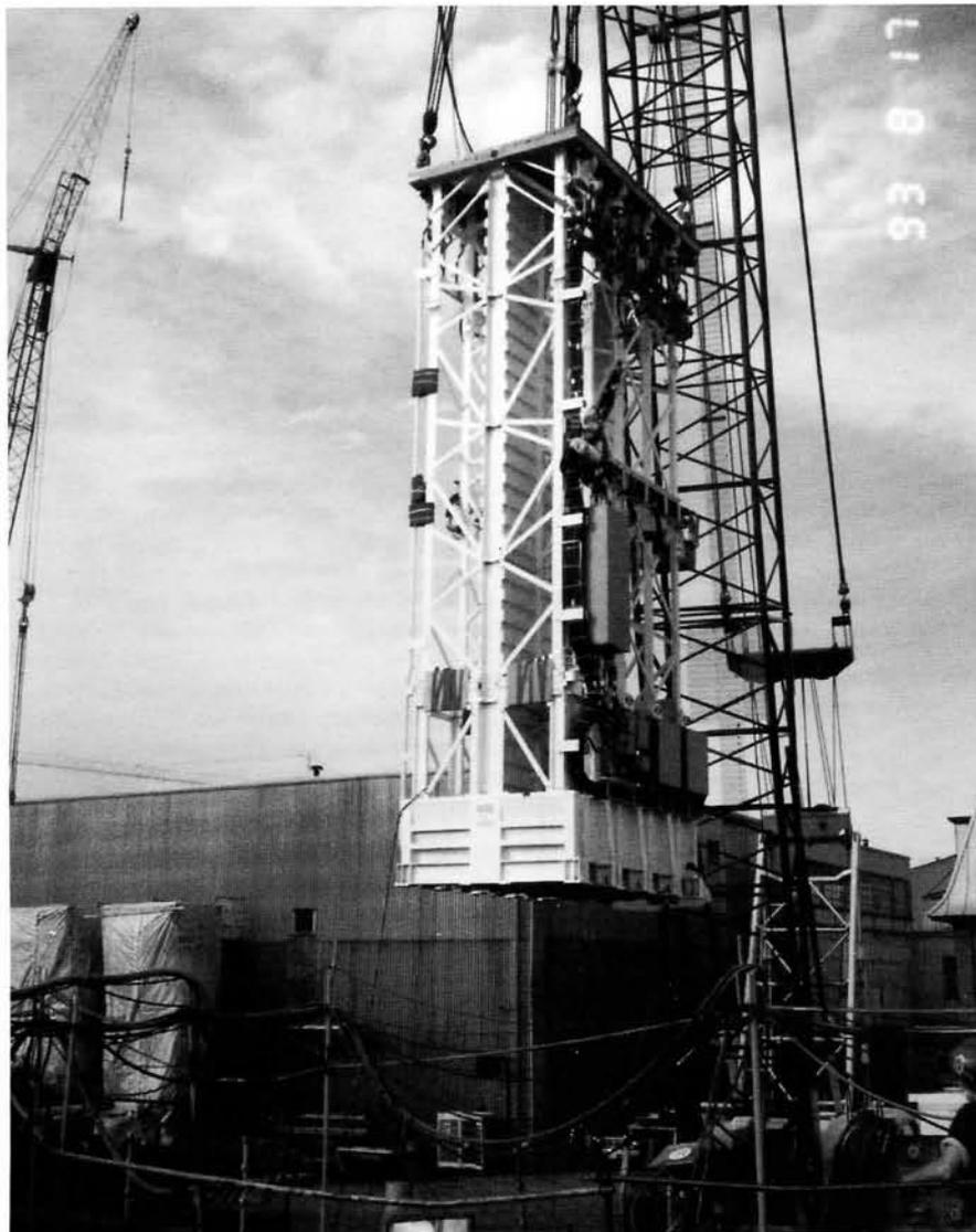
Fig. 7. Un module est transporté par grue au navire au cours de l'embarquement des modules
