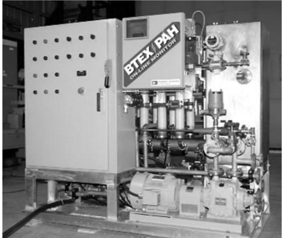
**Le nouveau séparateur huile/eau Hydromem<sup>MD</sup> devant être installé à bord des navires cet automne occupera le même emplacement que les appareils existants. On peut voir certaines des membranes d'ultrafiltration à gauche du grand réservoir de collecte des effluents qui se trouve à droite. Le contrôleur programmable se trouve à gauche. (Photo Water Technology International Corporation.)**
