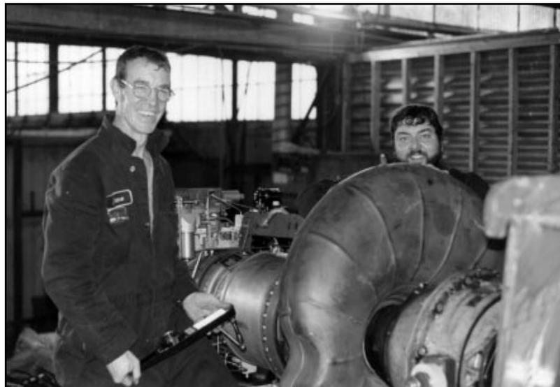
**Préparation des turbines à gaz Solar pour installation. Deux larges orifices d'accès étaient coupés dans le côté du navire au SMA pour pouvoir accepter la machinerie.**
