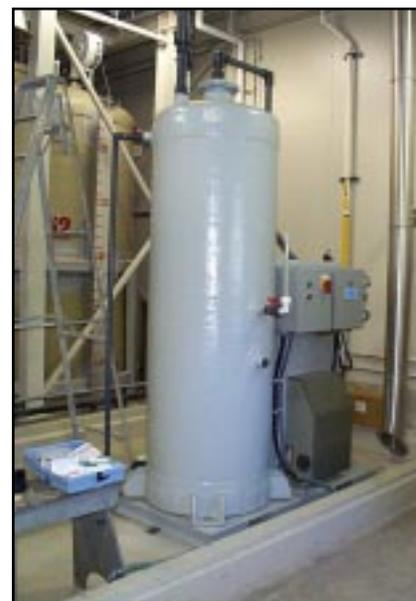
Figure 7. Oxydeur de cyanure
