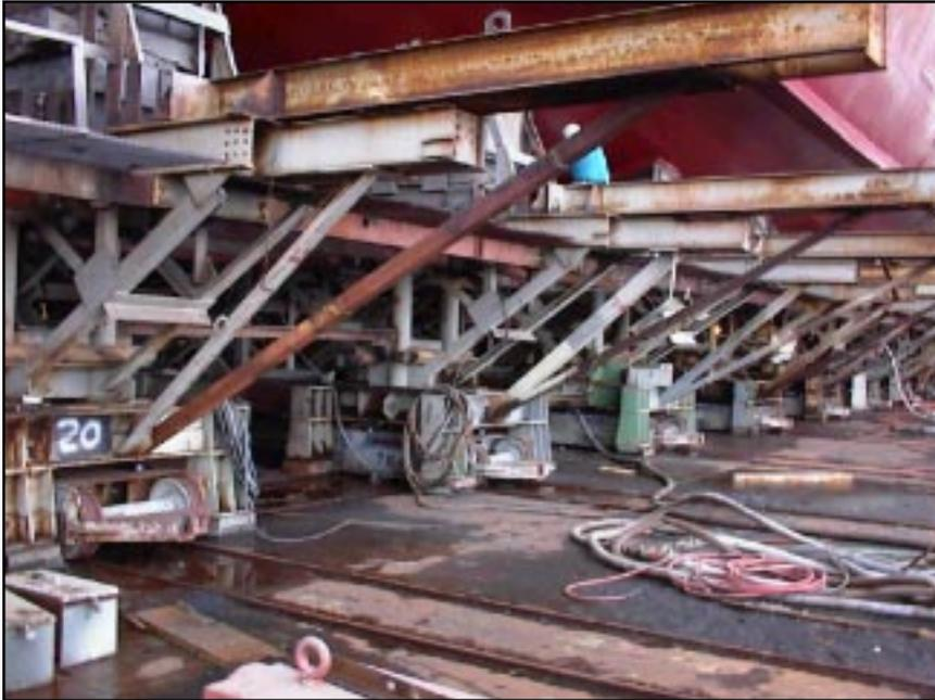
**Le berceau de construction du USS *McFaul* est monté sur des wagonnets électriques qui serviront à transporter le DDG assemblé dans le bassin flottant où seront effectués le lancement et l'achèvement de l'équipement (voir la photo sur la page précédente. (Photo courtoisie Ingalls Shipbuilding)**
