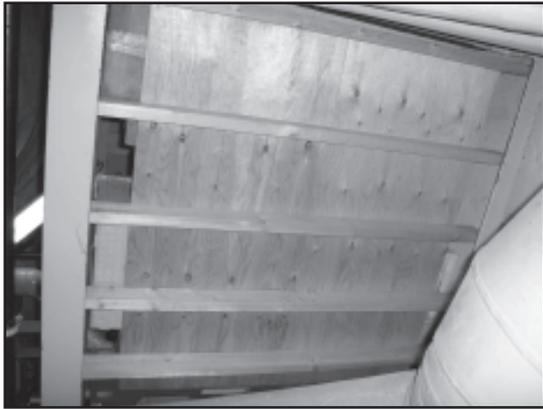
**Fig. 2. Plate-forme de stockage en bois posée dans le tambour avant du puits des machines d'un navire de classe *Halifax*.**
