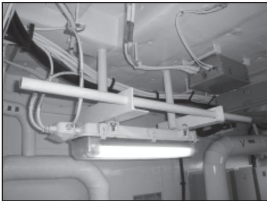
**Fig. 4. Cette barre de traction a été fixée aux supports d'un appareil d'éclairage, sur la plate-forme de la section arrière.**
