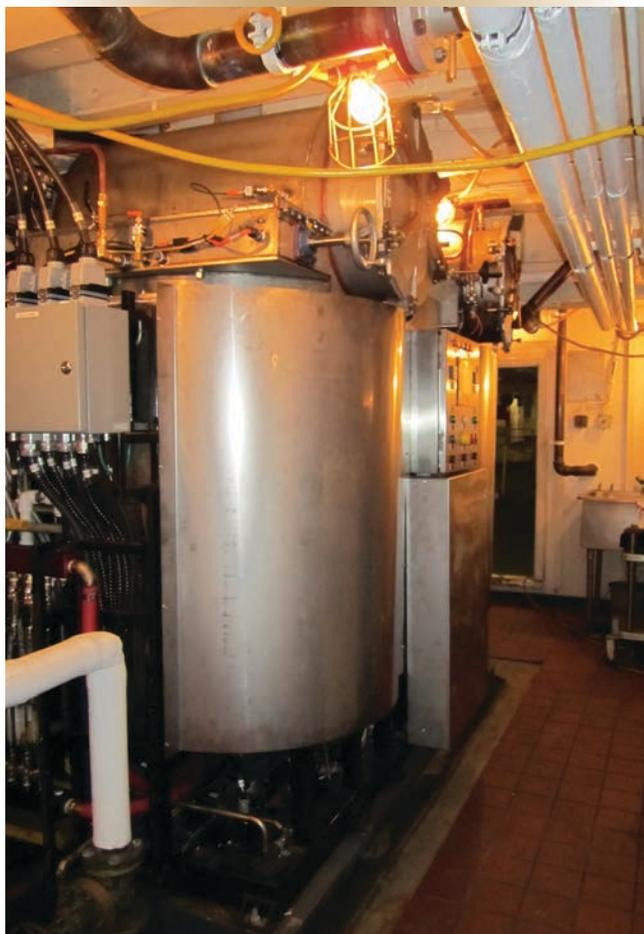
Figure 3 – MAGS 4.3 installé à bord du NCSM *Protecteur*
