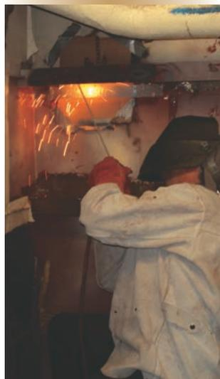
Le Matc Peters effectue une soudure au plafond pour renforcer un élément structurel de la coque.
