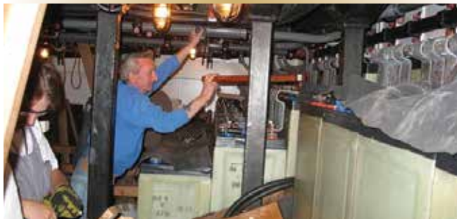
Travail serré. Un technicien installe un couvercle de levage sur un accumulateur avant de l'enlever.
