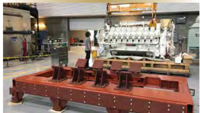
Carl Chamberland, chef de projet du CETM, se prépare à vérifier l'installation d'un moteur PAXMAN sur un bâti-moteur du banc d'essai.
