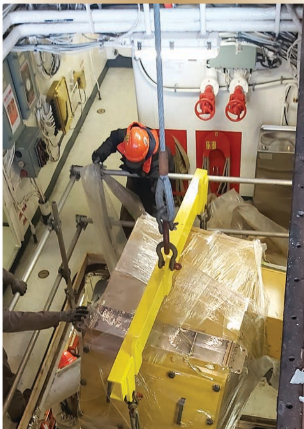
Figures 3a et 3b. Un nouveau groupe électrogène Hitzer est déplacé dans le hangar du navire et abaissé dans la salle des machines auxiliaires arrière.
